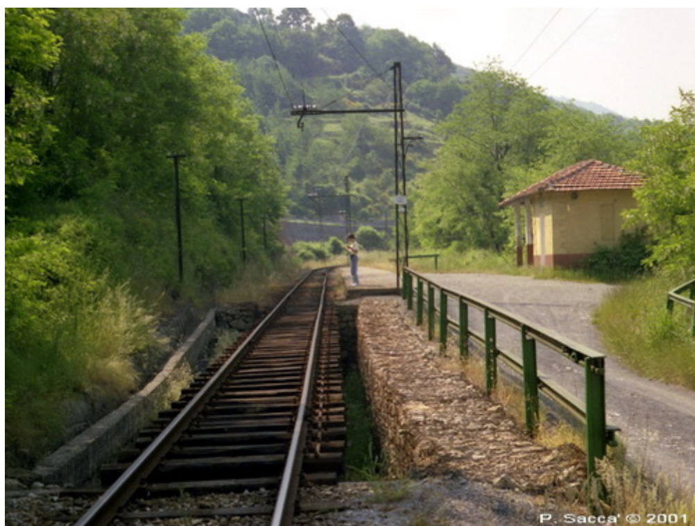
Foto travata metallica della Crocetta (fonte www.amicifgc.it )
