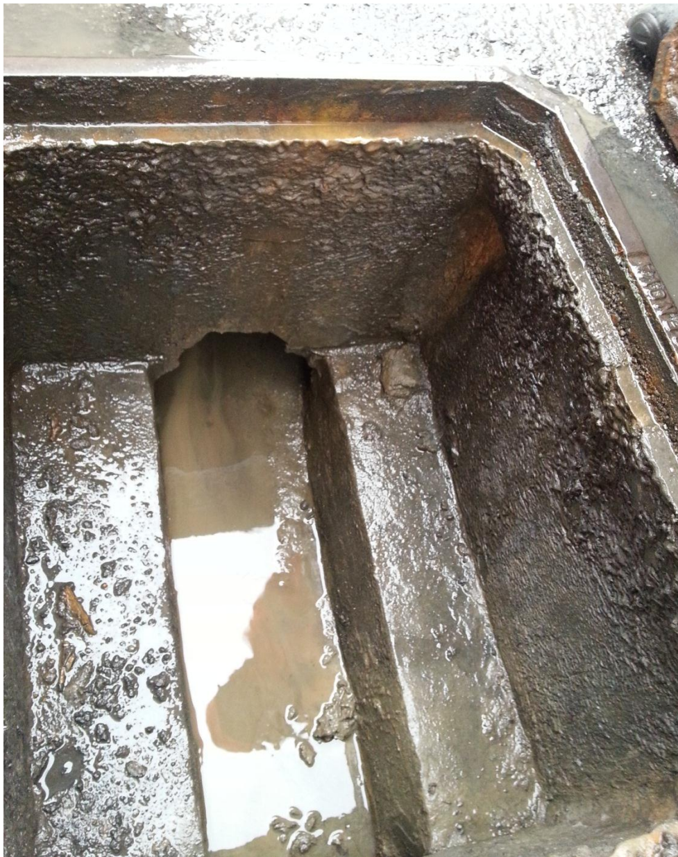
Foto 10: Particolare canalette di raccolta delle rete bianca in Piazzale Adriatico.
