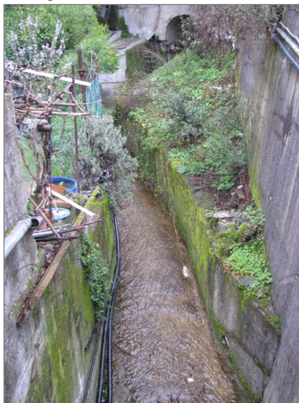
Figura 11: Ostruzione del flusso nel tratto a cielo aperto.
