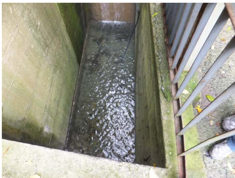
Figura 13: Vasca di sedimentazione di ridotte dimensioni.
