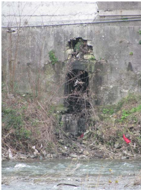
Figura 8. Sbocco ostruito del Rio Torre nel T. Bisagno.
