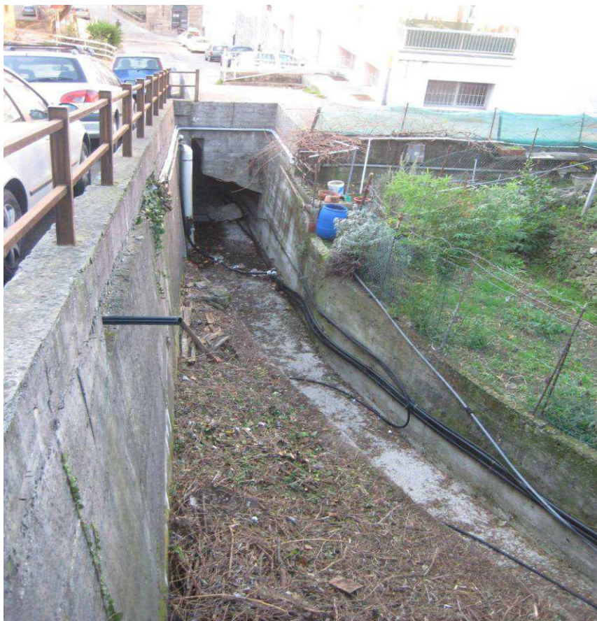
FOTO 5: Rio Torre - tratto intermedio a cielo aperto con imbocco tombinatura di valle
