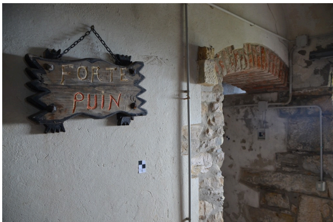
Altro particolare dell'interno.
