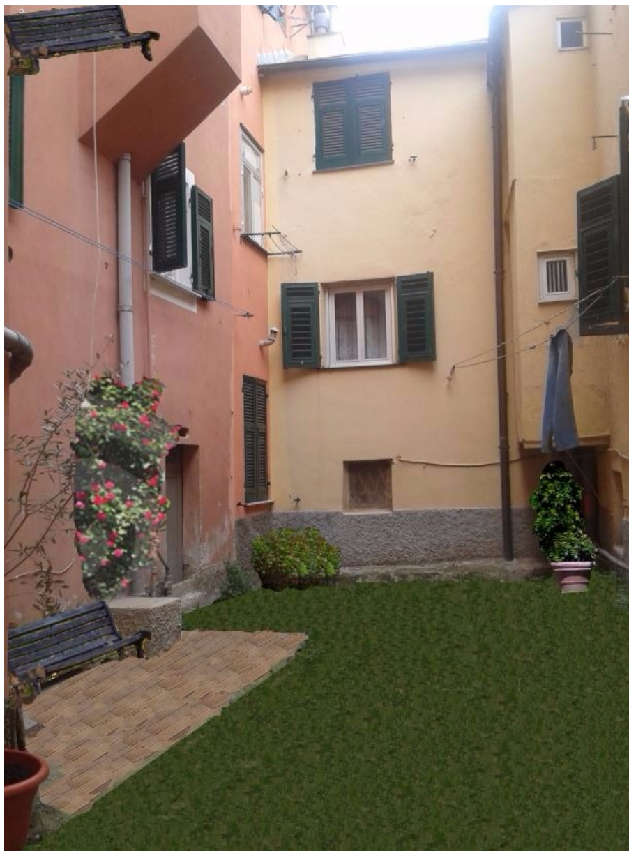
Nella foto sotto inizio dei lavori, tolto il cemento
