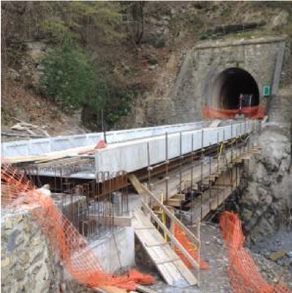
Foto 1 Posa delle predalle poco prima del getto della soletta (Fonte: gruppo Fb Ferrovia Genova Casella)
