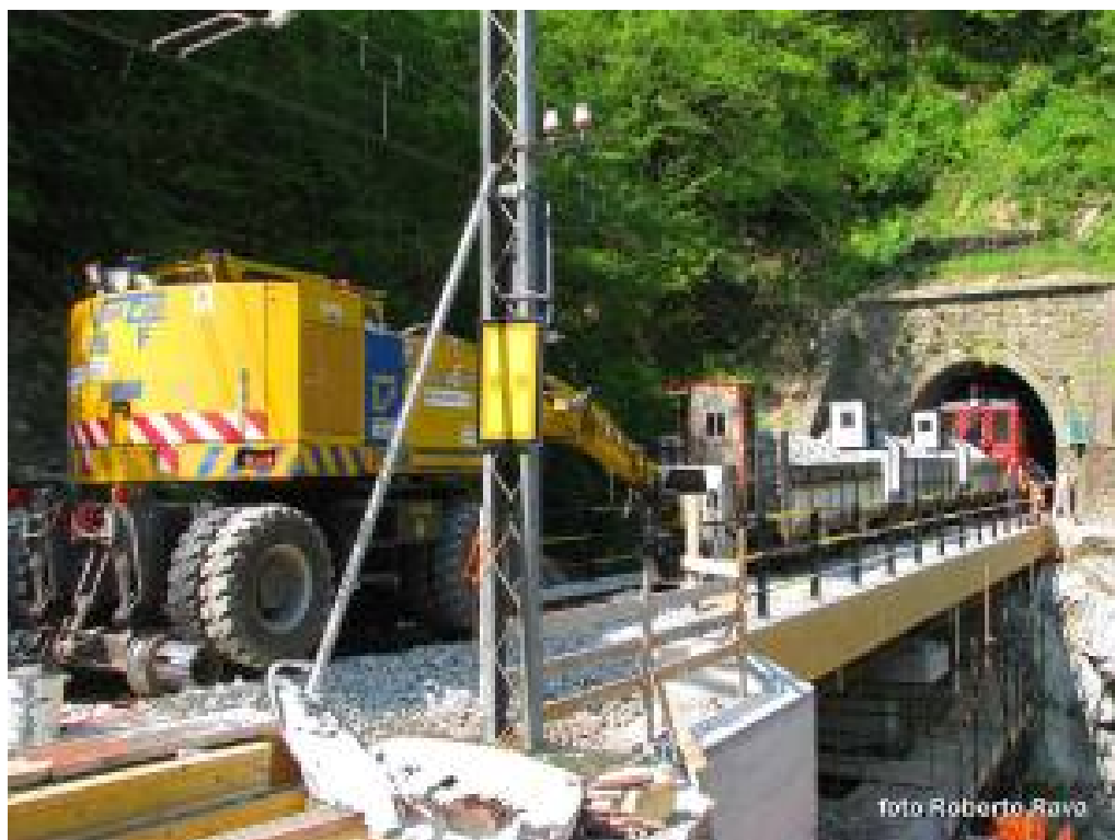
Foto 2 Ultimi carichi di pietrisco e rincalzi del binario sul ponte (Fonte: gruppo Fb Ferrovia Genova Casella)
