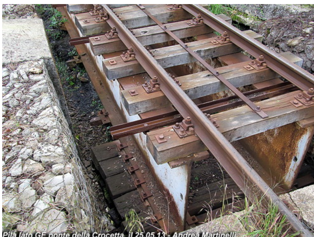
Particolare della travata metallica della Crocetta (fonte www.amicifgc.it )
