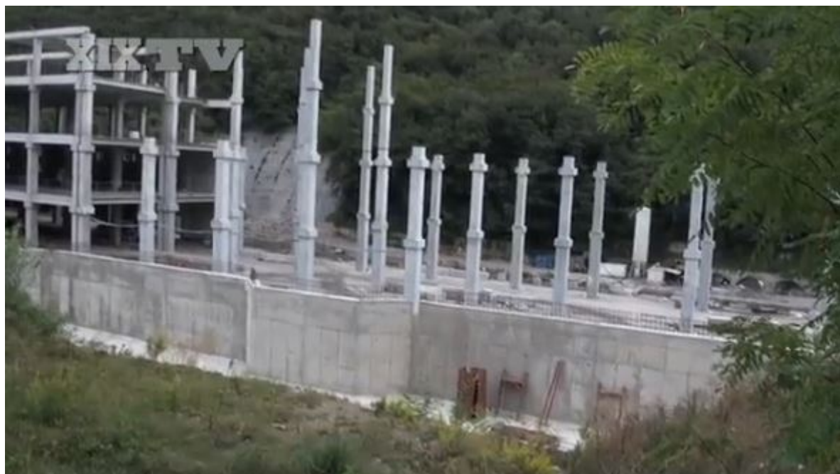
Ponte Carrega - occasione mancata
